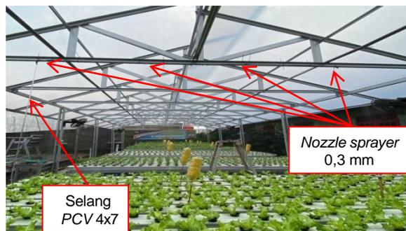
Gambar 8. Rancangan sistem *sprayer* otomatis
